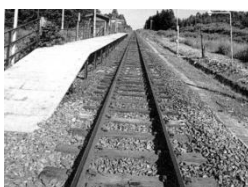
铁轨铺在枕木上 B
