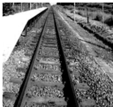
火车铁轨下铺枕木
